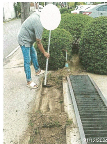
รูปภาพที่ 2.32 การขุดลอกตะกอน
